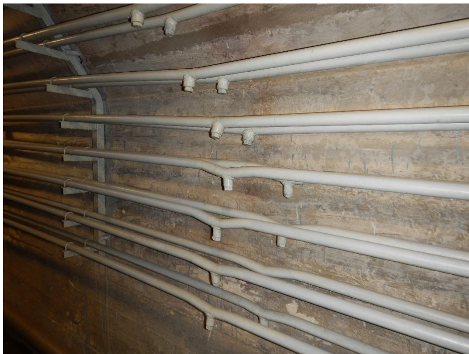
Detail vypouštěcích zátek v nejnižším místě potrubí
