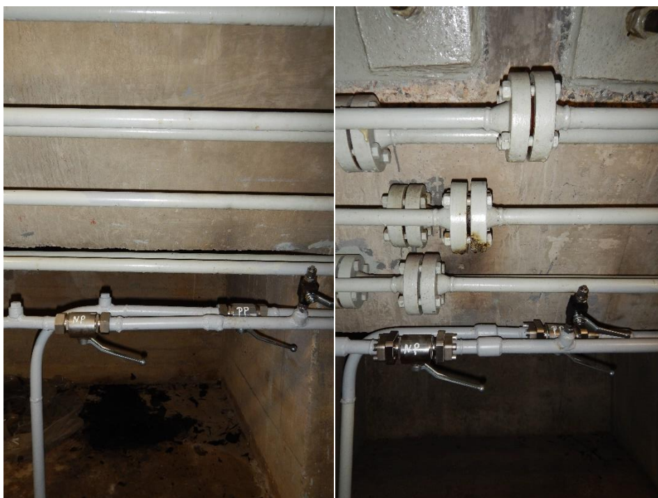
Dva detaily uzavíracích ventilů před servomotory
