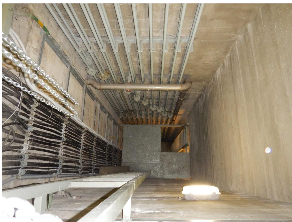
Pohled na hydraulické rozvody ze strojovny do svislé šachty
