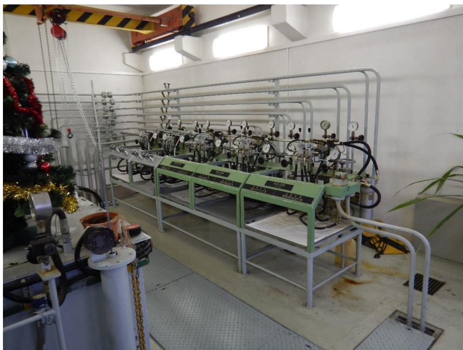
Celkový pohled na regulační konzoly – vpravo hydraulické rozvody směrem k olejovému hospodářství
