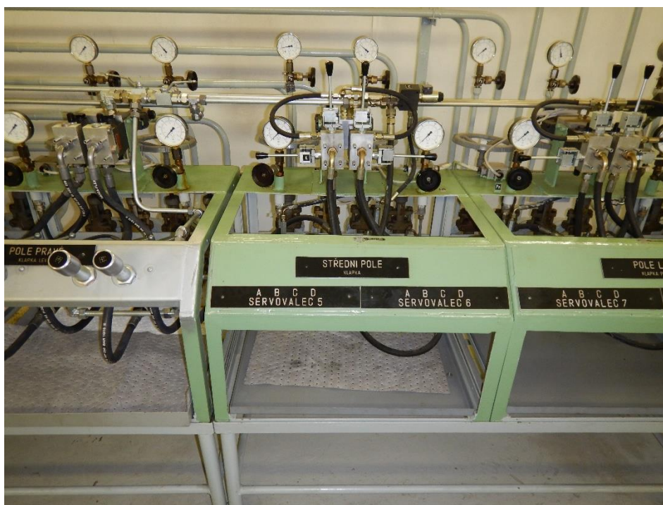
Detail regulační konzoly středního jezového pole
