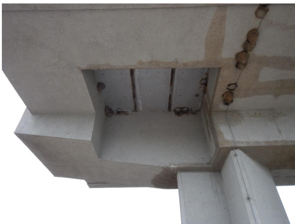
Detail zakrytovaného montážního otvoru
