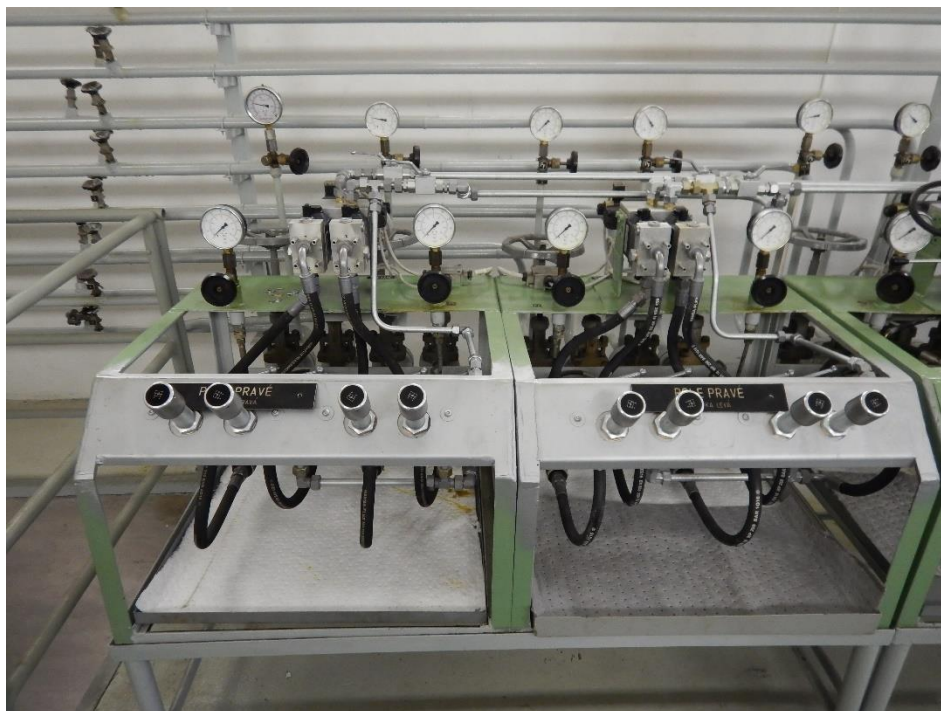
Detail regulačních konzol pravého jezového pole
