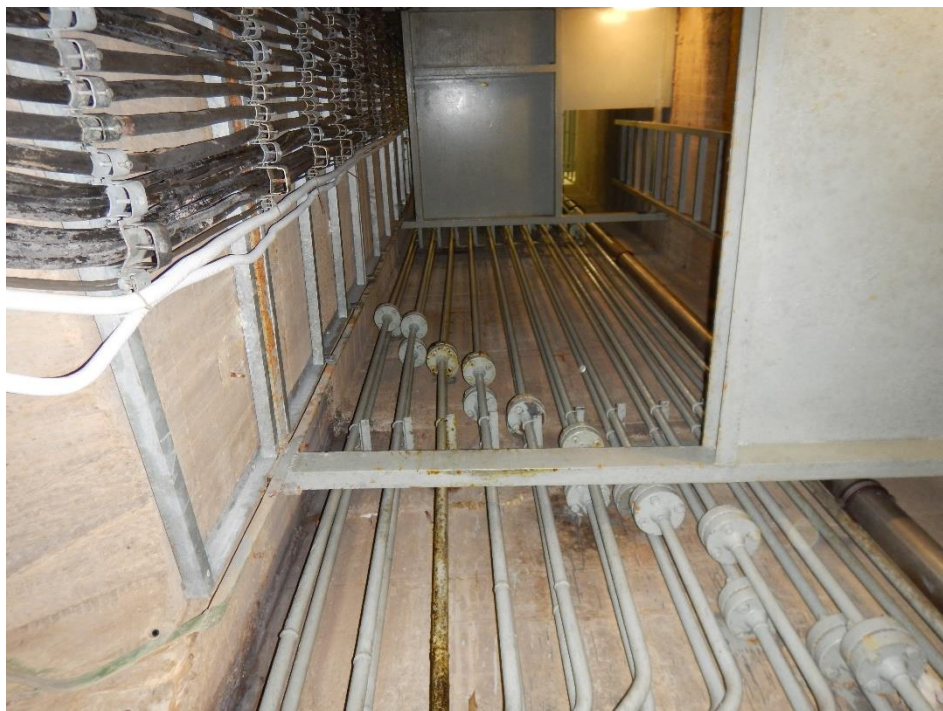
Pohled na hydraulické rozvody z jezové štoly do svislé šachty
