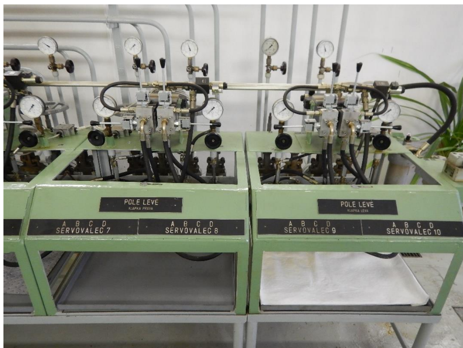
Detail regulačních konzol levého jezového pole
