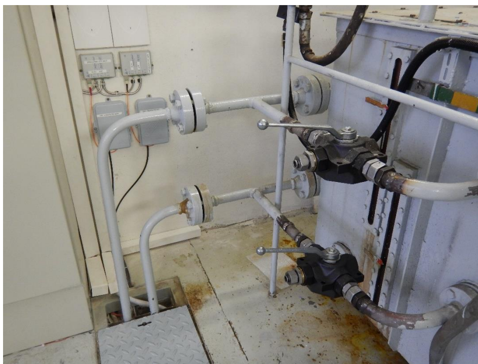
Detail napojení hydraulických rozvodů od regulačních konzol K olejovému hospodářství
