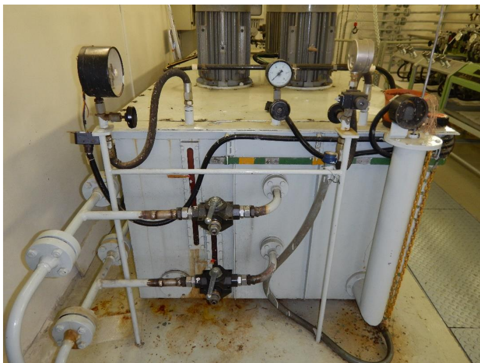
Pohled na technologické zázemí hlavního olejového hospodářství – vlevo dole napojení hydraulických rozvodů
