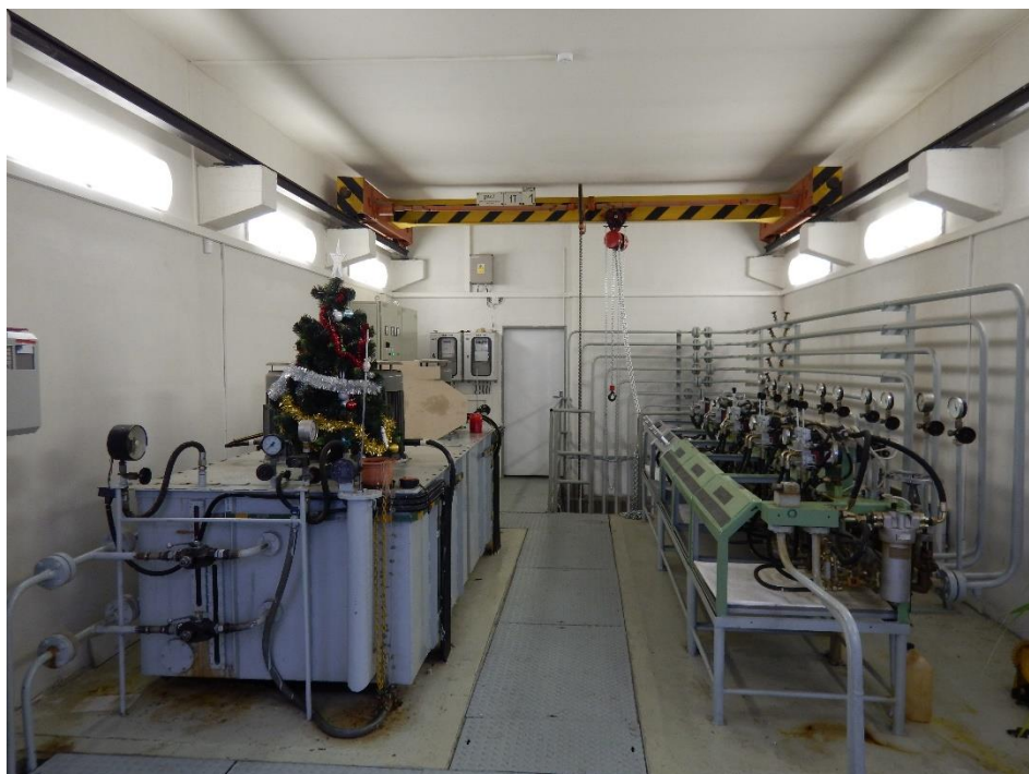
Východní pohled do strojovny ve velínu – nahoře mostový jeřáb s kočkou
