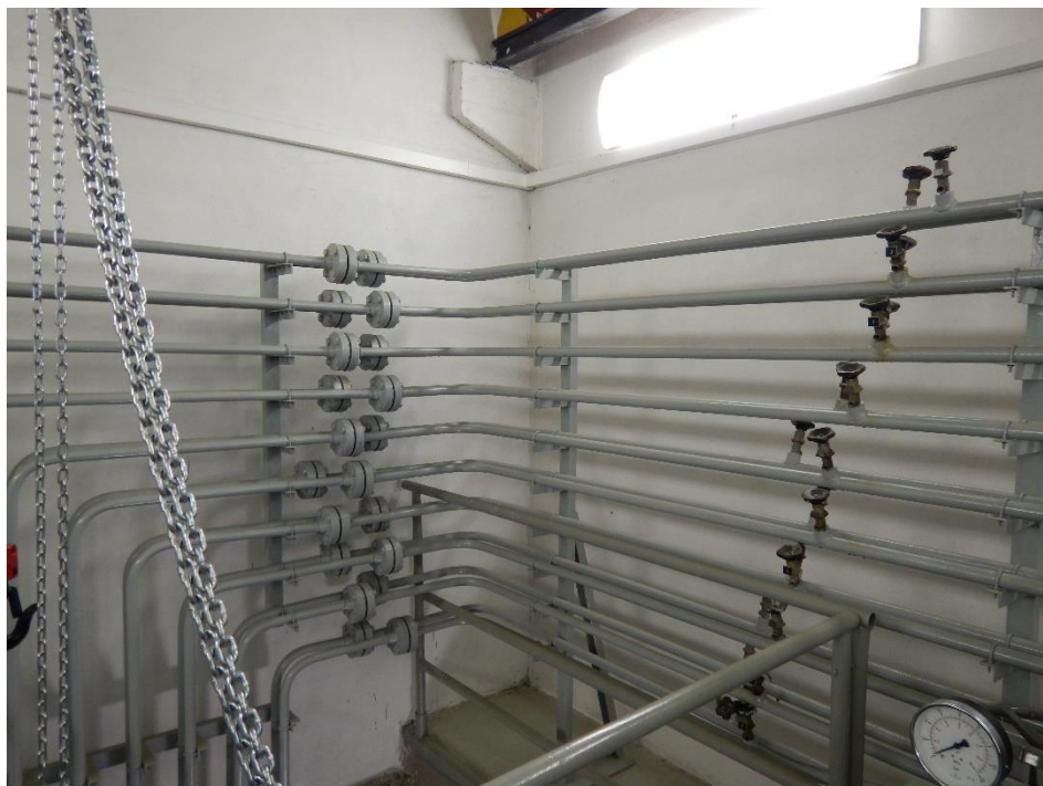
Pohled na hydraulické rozvody ve strojovně - vpravo odvzdušňovací ventily
