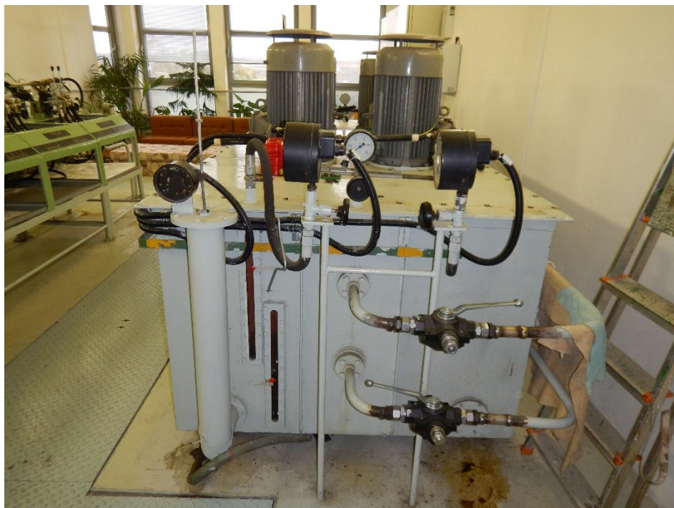
Pohled na technologické zázemí rezervního olejového hospodářství – vpravo napojení hydraulických rozvodů
